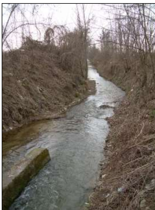
Figura 11: sezione di canale su cui è stata effettuata la misura di portata – fontanile Lagot
