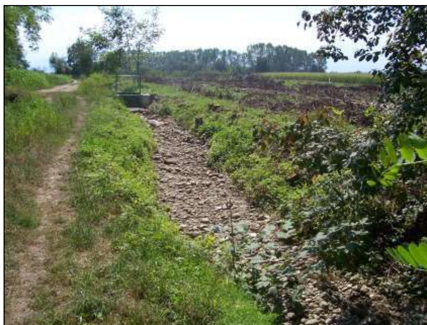
Figura 17: tratto in secco a monte della confluenza con il canale alimentato dal fontanile Lagot.
