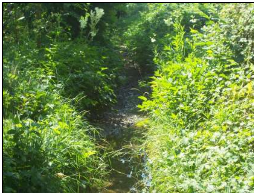
Figura 18: canale Trebbi in secco
