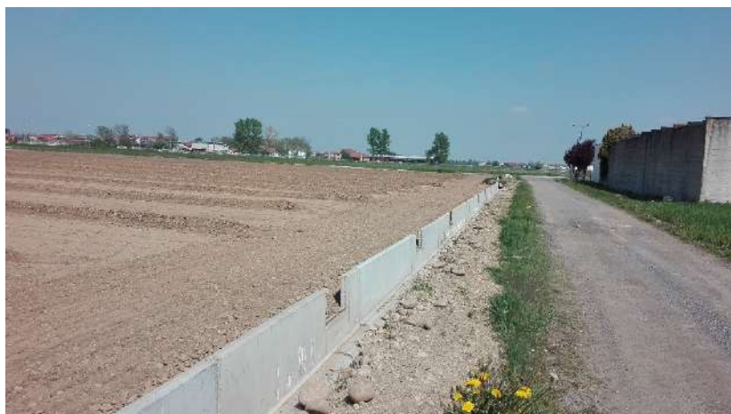
12. Settore limitrofo al cimitero di Montanera
