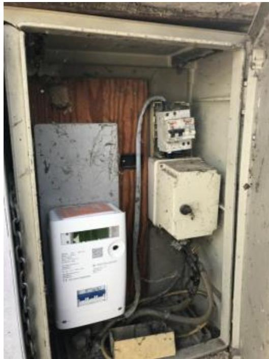
All'interno della nicchia esistente viene posato un nuovo quadro elettrico in materiale isolante, autoestinguente, grado di protezione minimo IP 55, con portella di qualsiasi tipo (cieca, trasparente o fume), guida DIN, compreso ogni accessorio per la posa in opera. Centralino da 12 moduli. L'interruttore magnetotermico differenziale esistente viene recuperato e riutilizzato all'interno del nuovo quadro.
