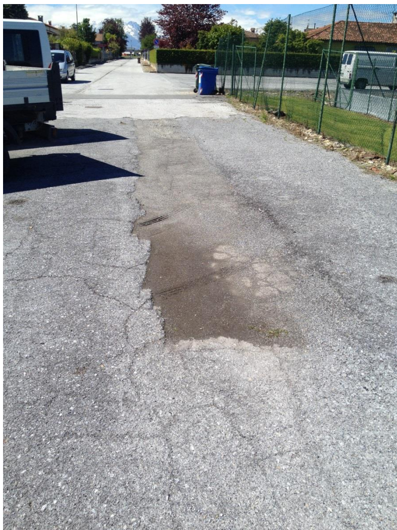
FOTO 13 – PORZIONE DI RIPARAZIONE LOCALIZZATA DEL MANTO STRADALE – VIA BORGO NUOVO
