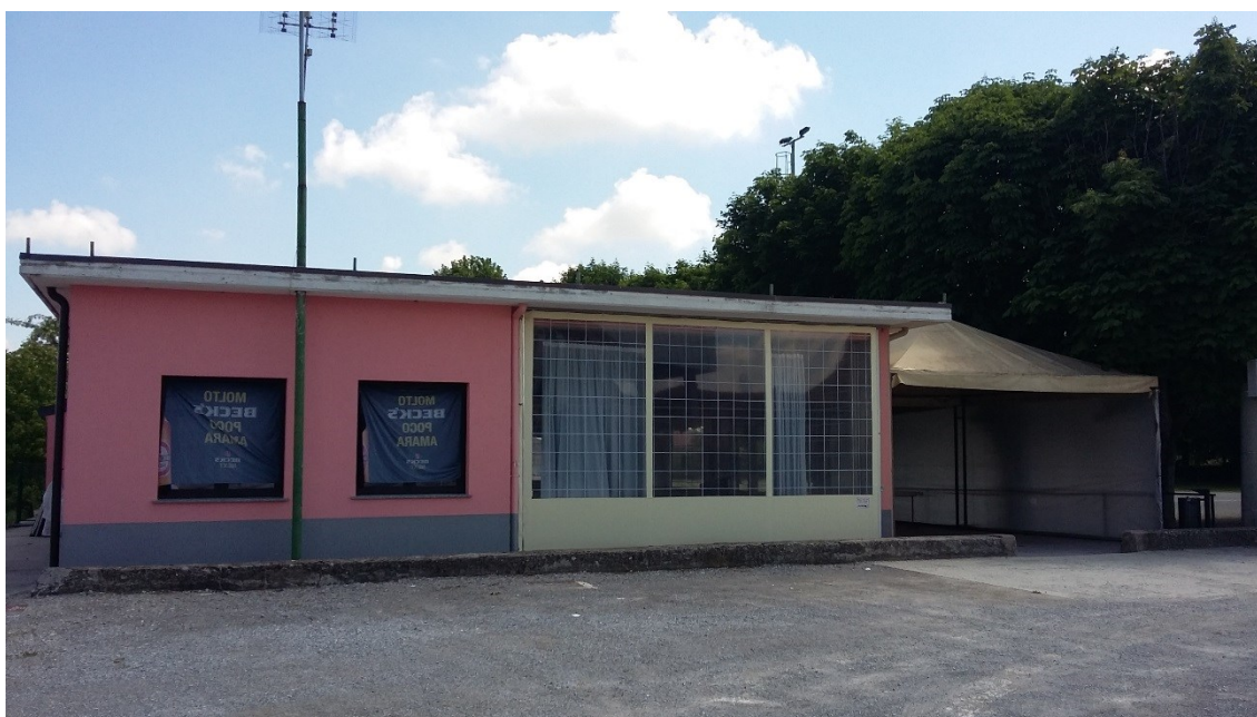
Foto 2 – Edificio oggetto di intervento, lato ovest
